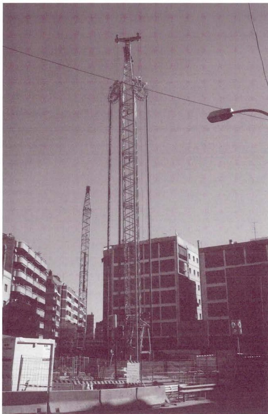
Obres de la línia 9 al barri de Collblanc, a l'Hospitalet. Foto Arxiu Territori
