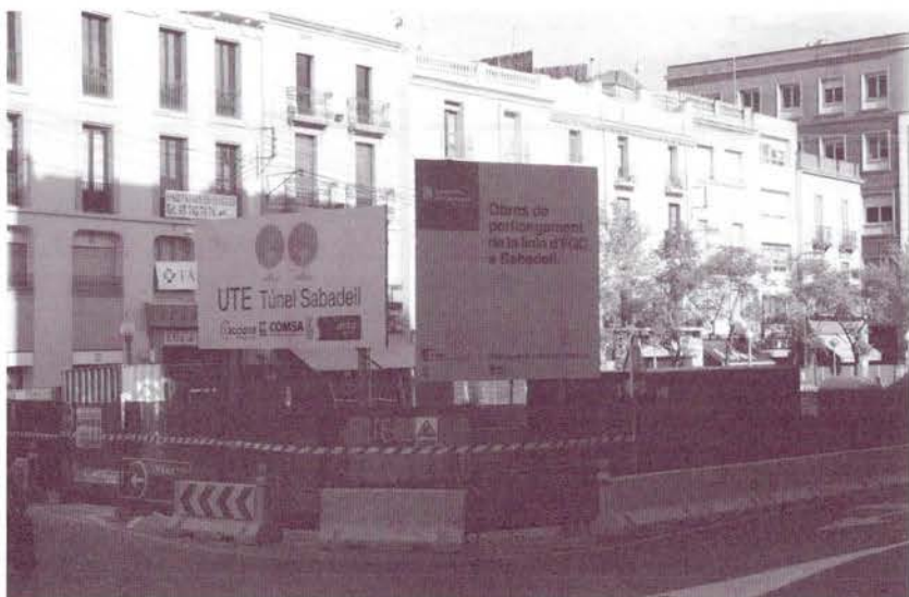
Obres de construcció del túnel dels FGC a Sabadell. Foto Arxiu Territori
