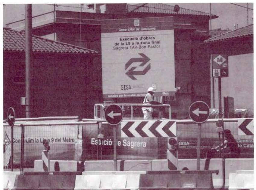
Obres de la línia 9 a la Sagrera. Foto Arxiu Territori
