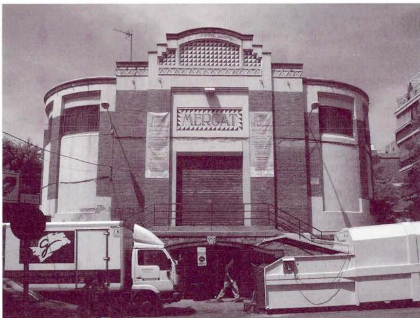
Es rehabilitarà el mercat Segarra. Foto Moisès Jordi
