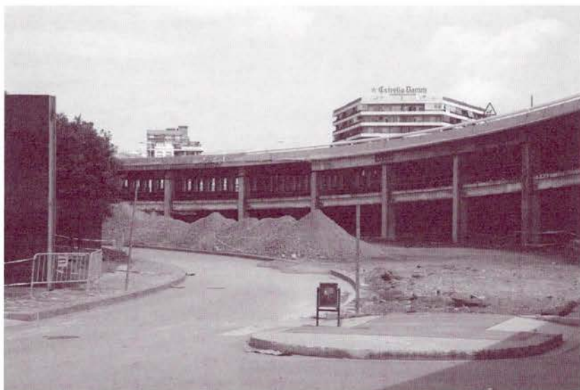
Obres de deconstrucció del tambor de la plaça de les Glòries. Foto Anxí Territori
