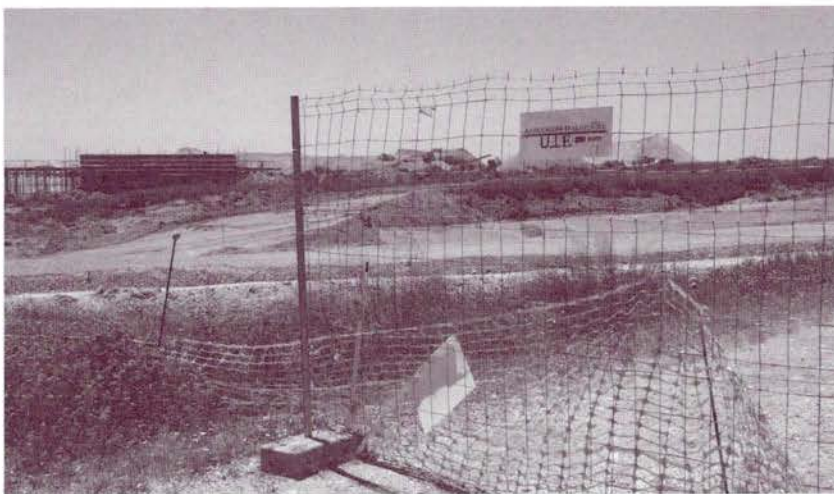
Detall de les obres de l'aeroport. Foto Arxiu Territori
