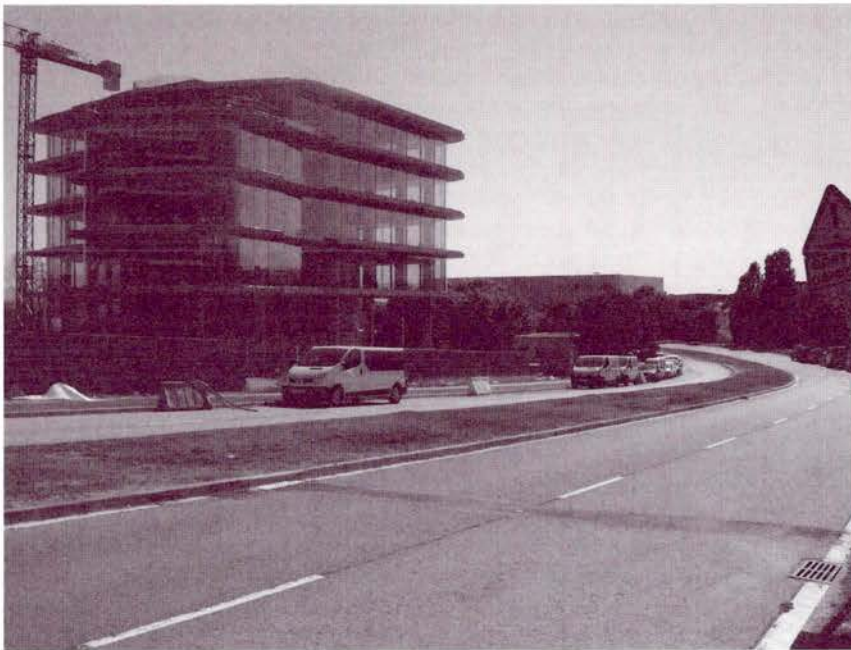
Tram en servei de l'autovia interpolar al polígon de Can Sant Joan. Foto Moisès Jordi
