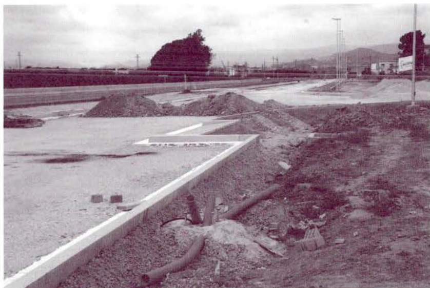
Obres d'urbanització al Parc Tecnològic del Camp. Foto Arxiu Territori
