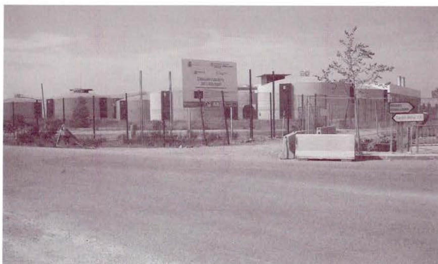
Desalinitzadora del Llobregat. Foto Moisès Jordi
