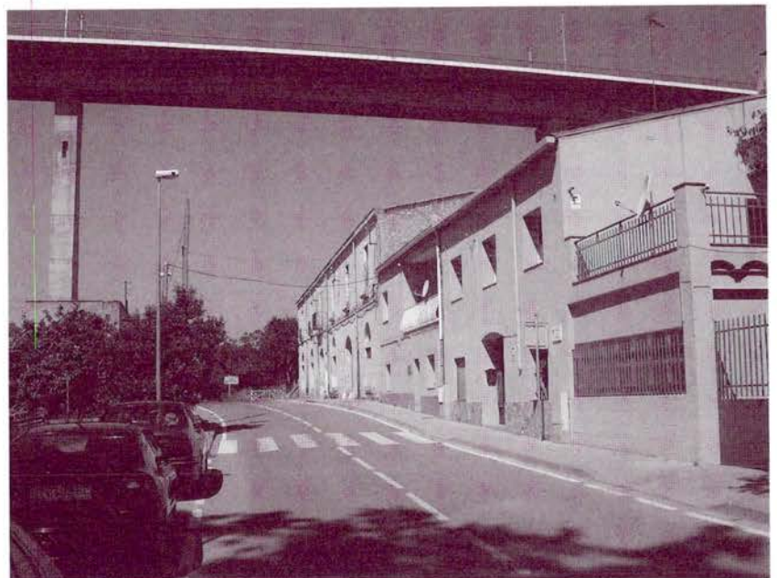
Pas del FAV per Pont de Molins. Foto Moisès Jordi
